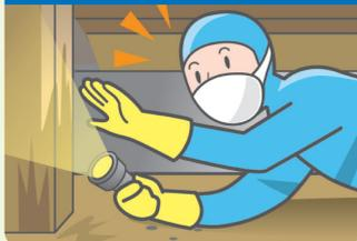
床下に入り、大引や根太などの木部およびコンクリート部分にシロアリ被害の兆候がないかを確認します。
