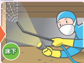
床下点検口から床下へ進入し、全ての束柱・コンクリート基礎の角部の土台、そして、床全面(土もしくはコンクリート)に薬剤処理を行います。
